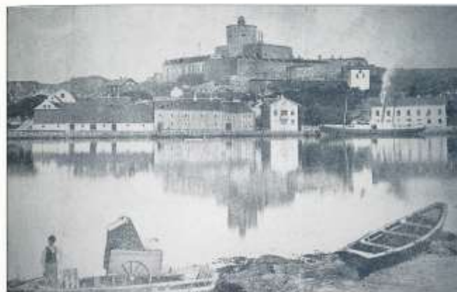
Bilden är en avfotografiering av en enorm förstoring i Marstrand Hembyggsförenings ägo. ALBREKTSUND kom till Marstrand första gången 22 januari 1870. På Carlstens fästning ryms fyren som släcktes när Hannekör tändes 1 november 1868. På fästningen ryms även den opriska telegrafan som ersattes av den elektriska 13 juli 1871. Den senare var inrymd i Rådhuset, t o m gavelhuset, och försågs med en ihyll mot kajen. Skytten saknas på bilden. Rådhuset brann ned 1947.
