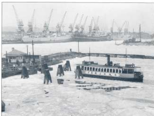
Bilden visar Götaverkens färjeläge vid resterna av det som tidigare var T-kanalen. Sommaren 1954 flyttades trafiken till ett nytt färjeläge i Lundbyhamnen. Foto från Götaverken samiskt vintern 1954.
